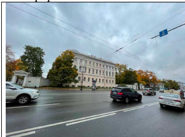
Фото 1. Ближайшее окружение Объекта оценки (Невский проспект)
