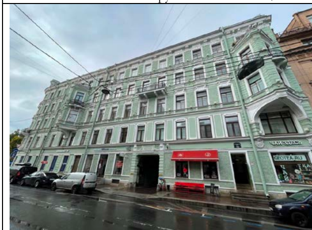
Фото 21. Вид здания Объекта оценки (с улицы Невского проспекта)
