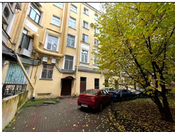
Фото 28. Вид здания расположения Объекта оценки
