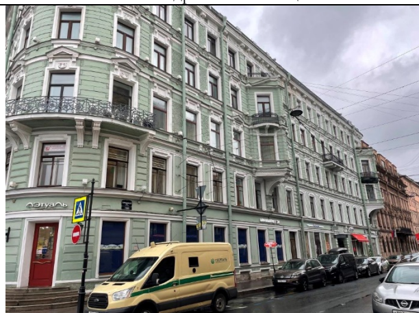
Фото 22. Вид здания Объекта оценки (с улицы Караванная)
