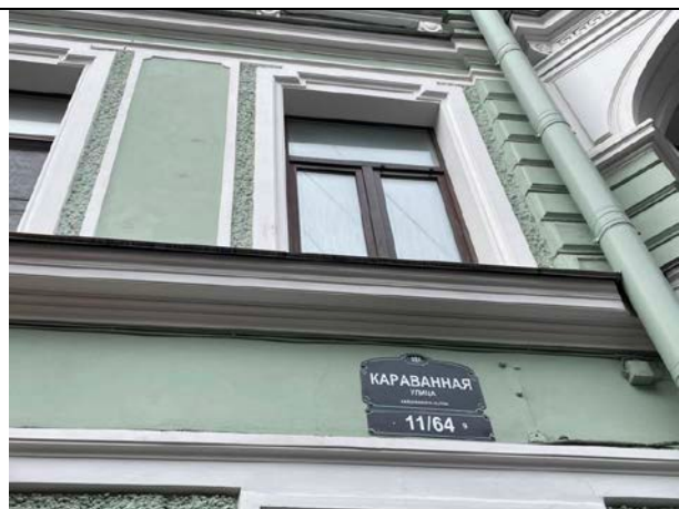
Фото 20. Адрес Объекта оценки
